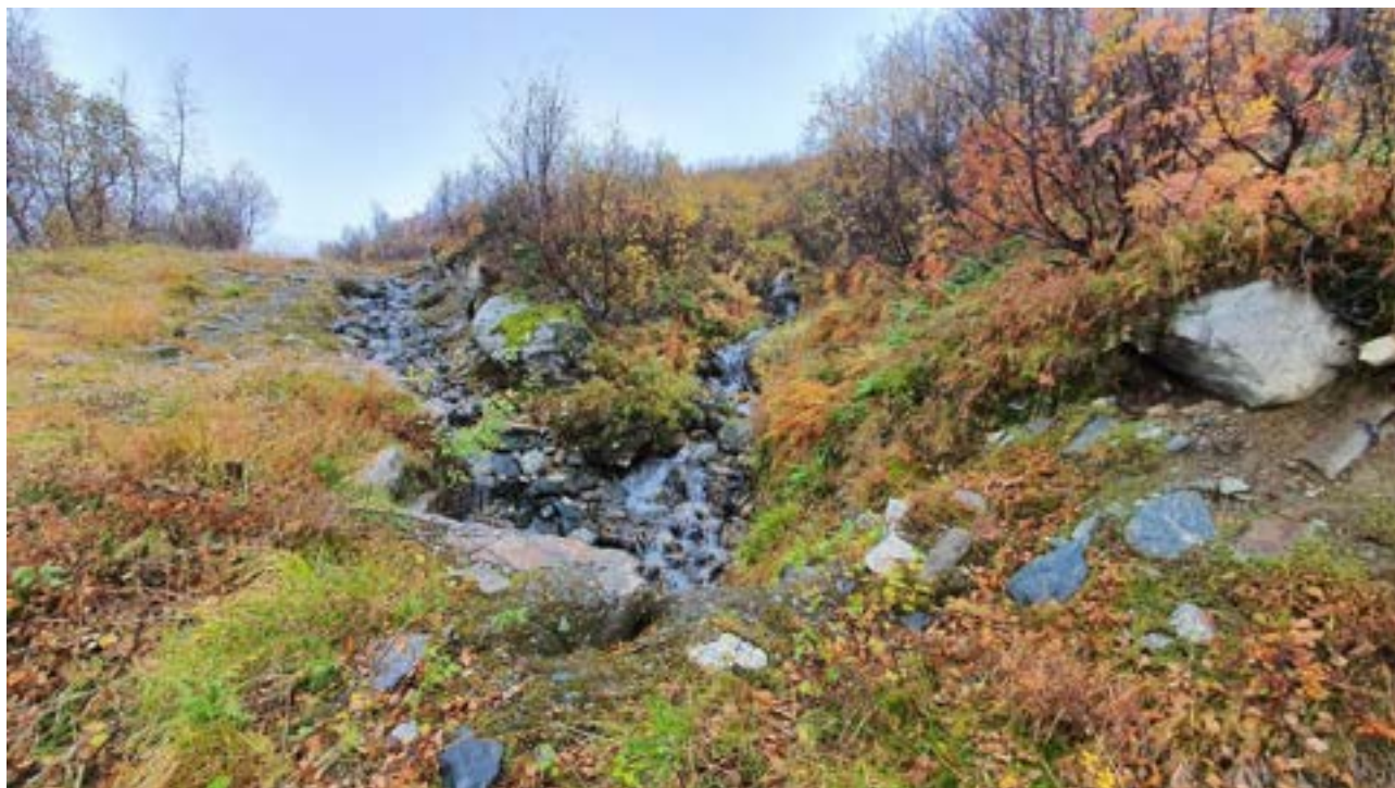
Figur 23: Foto av nedskjært bekkeløp ved skogsbilvegen.
