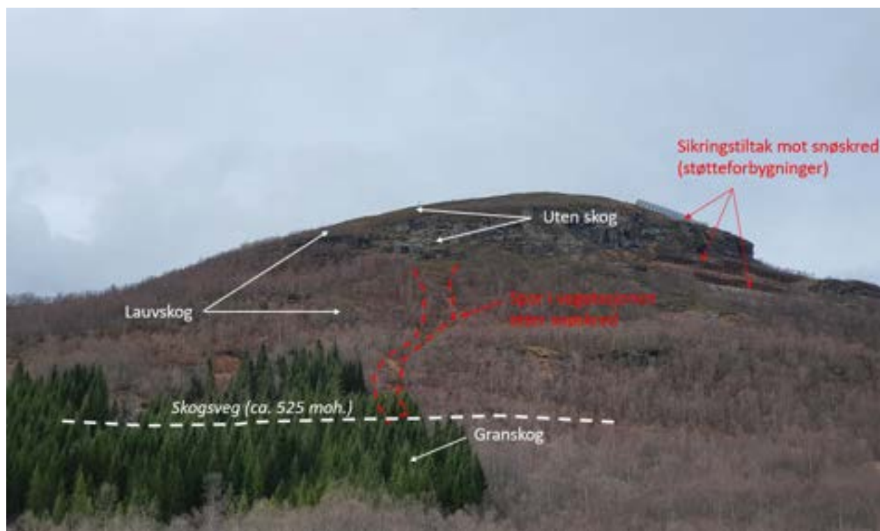
Figur 15: Foto fra tidligere rapport [3] som viser sikringstiltak mot snøskred. Se Vedlegg 3 for eksakt plassering av tiltak.
