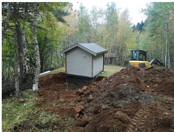
Frå arbeidet med utviding av vannbehandlingsanlegget på Øvrebust
