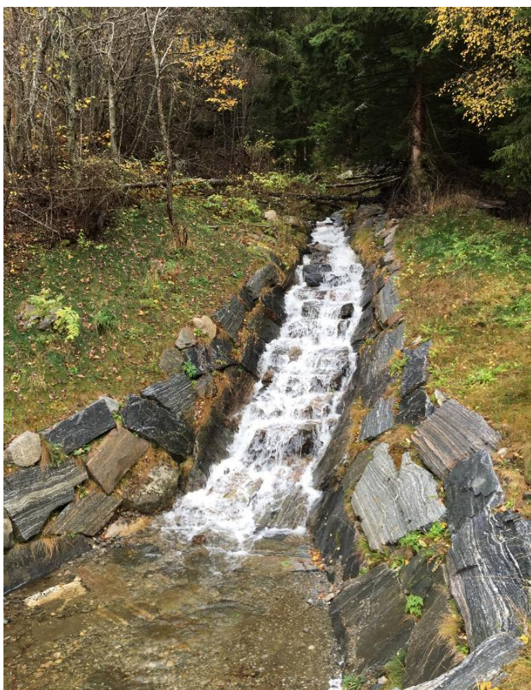
Figur 5-47 Erosjonssikring i nedre del av bekk på Langreiten
