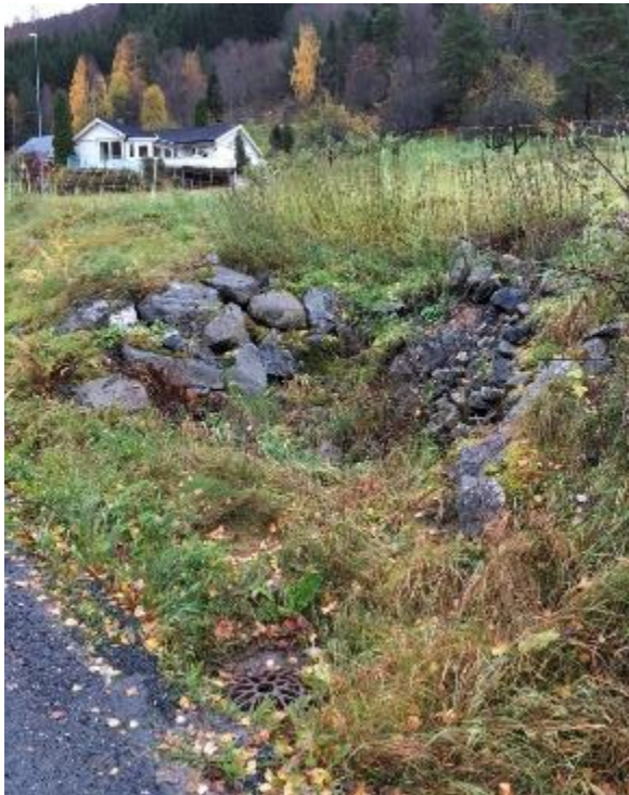
Figur 5-22 Innløp (kum) og utløp av stikkrenne ved Hjelle
