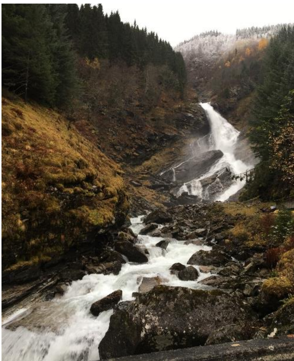
Figur 5-29 Dyrdøla oppstrøms bru
