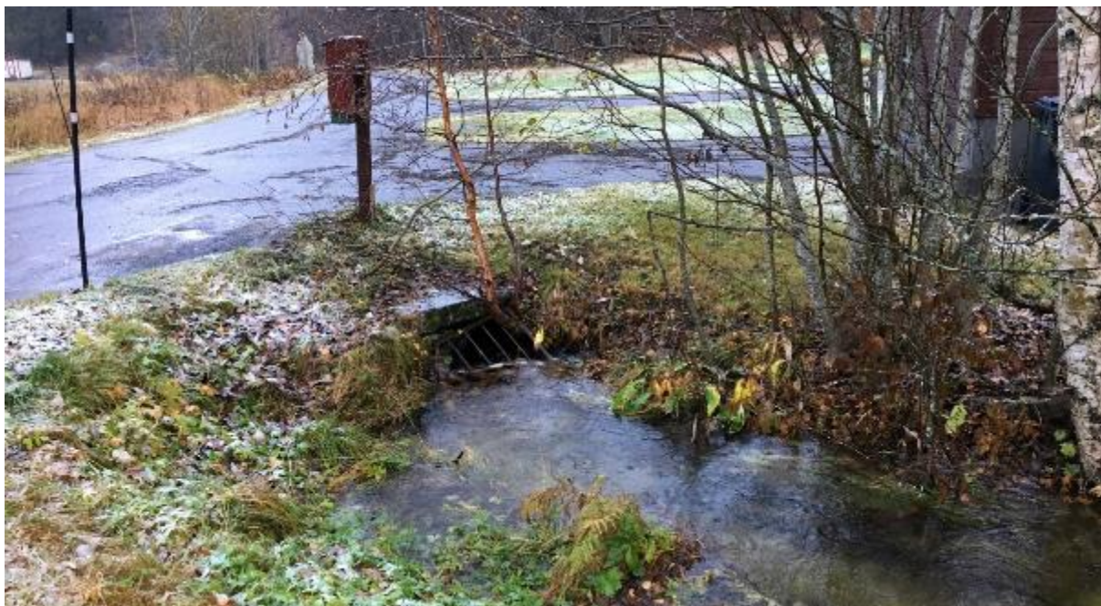
Figur 5-3 Stikkrenne - innløp
