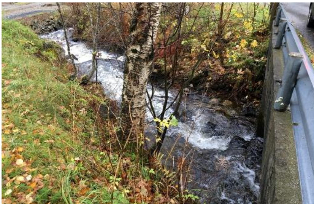
Figur 5-34 Skulevegenpkt 17, bru - utløpsside
