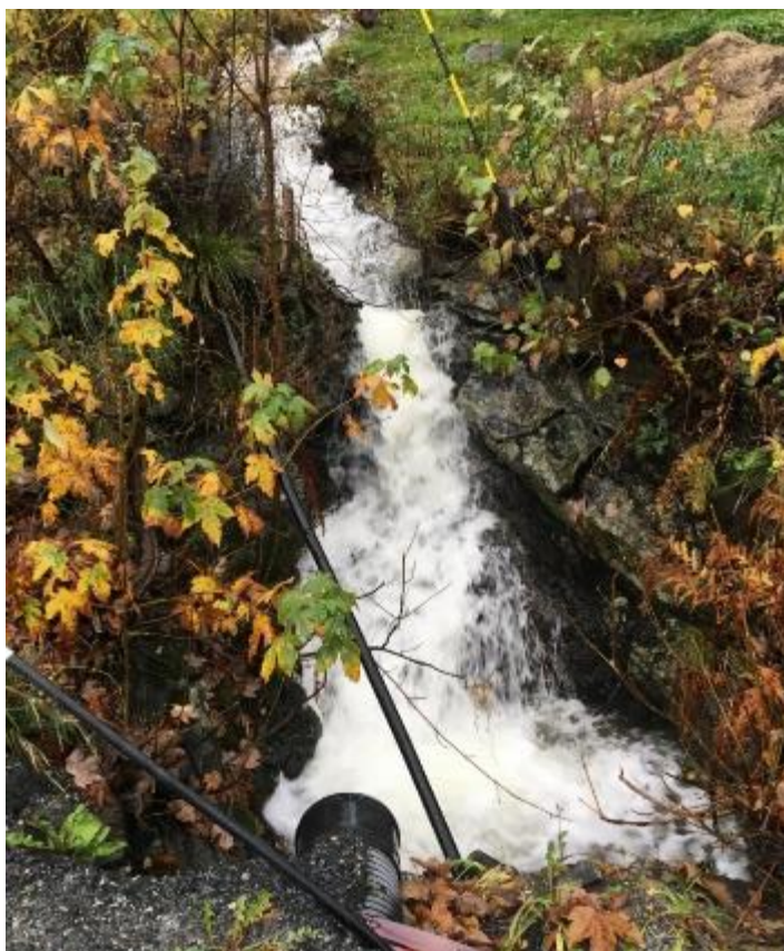
Figur 5-12 Bekk krysser under veien i to rør som ligger på fjell. Røret som vises på bildet skal fungere som flomløp.
