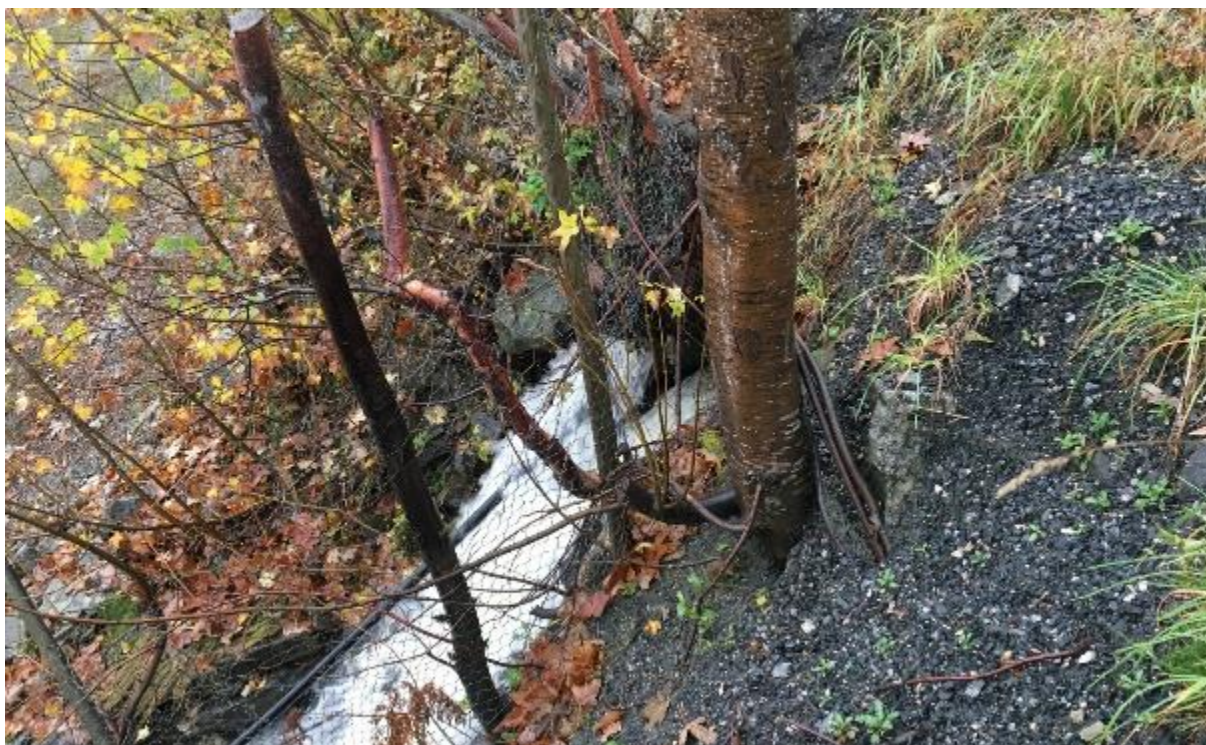
Figur 5-13 Utløp av stikkrenner
