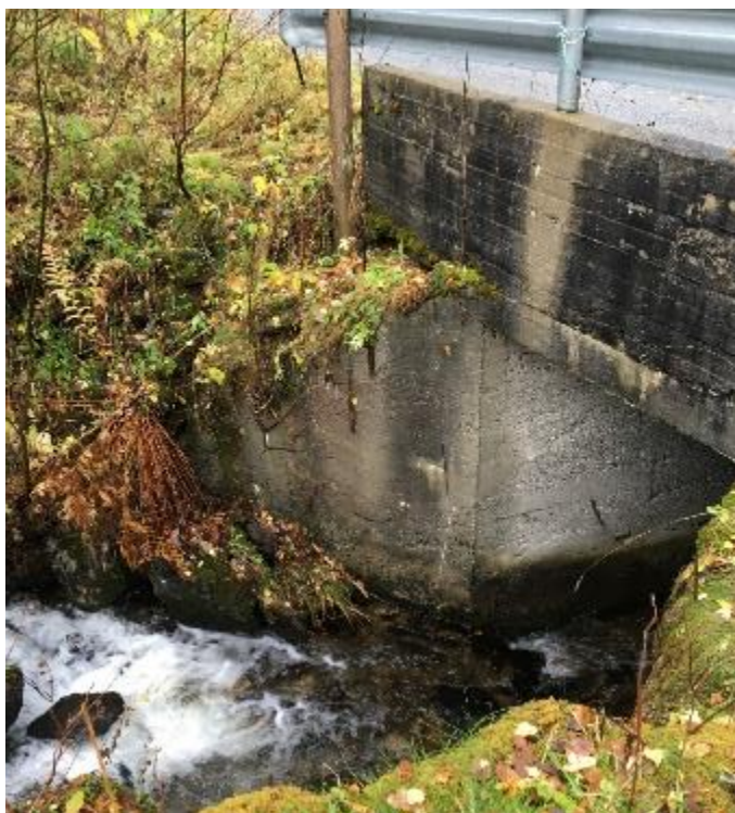
Figur 5-35 Skulevegen pkt 18, bru - innløpsside
