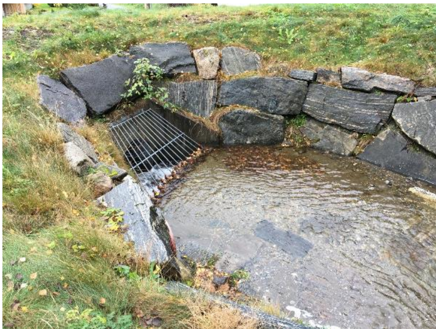
Figur 5-46 Innløpsbasseng og kulvert - Langreiten
