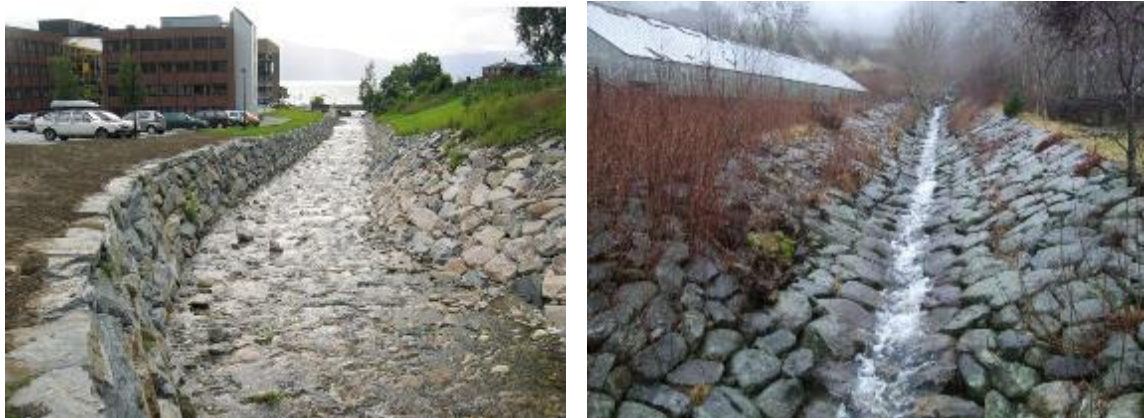
Figur 3-1: Eksempel på erosjonssikring av bekker med ulik størrelse. Bildene er hentet fra NVE.
