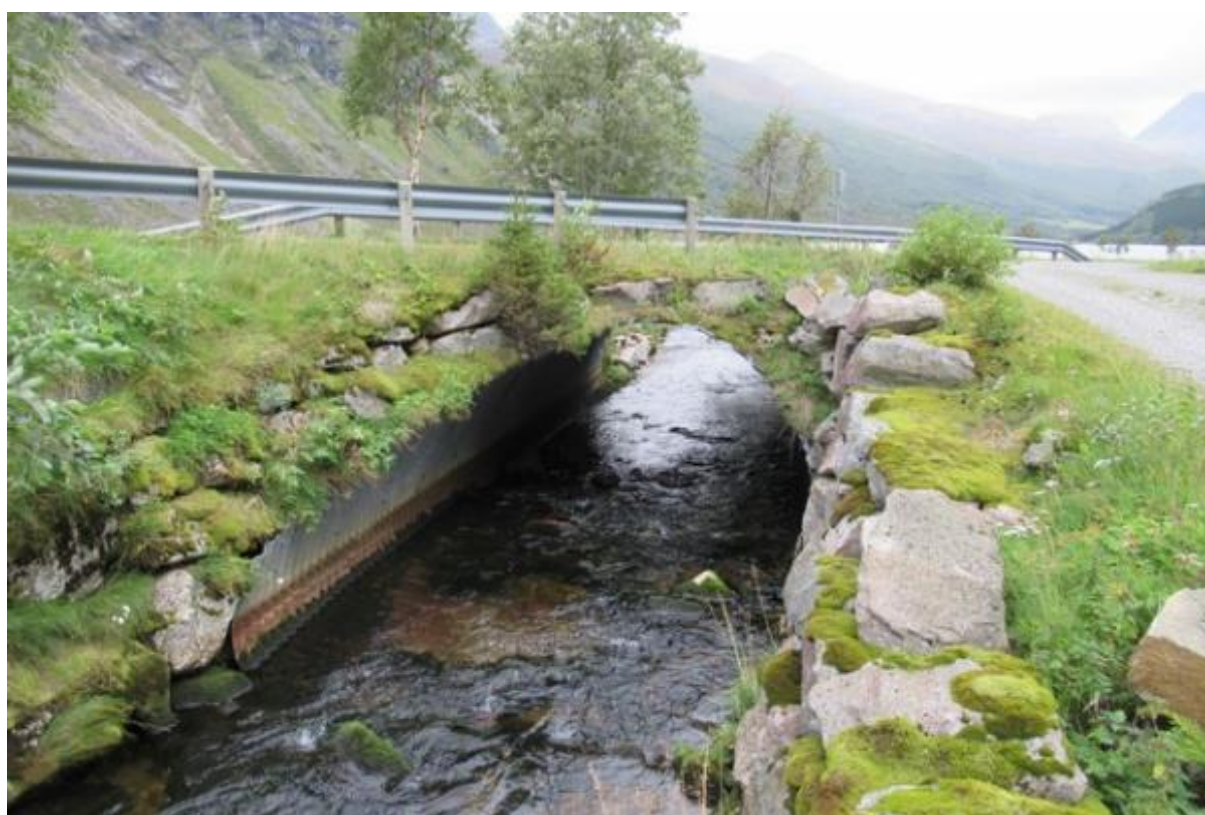
Figur 5-41 Indreeide bru (Foto fra bruinspeksjon).
