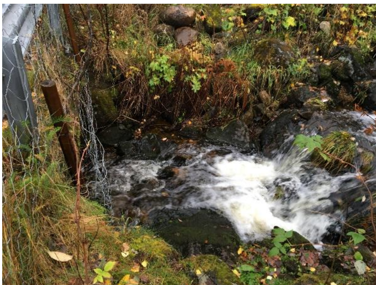
Figur 5-25 Innløp av stikkrenne ved Hjelle/Dalen (pkt 12)
