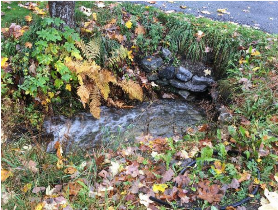
Figur 5-11 Utløp av stikkrenne
