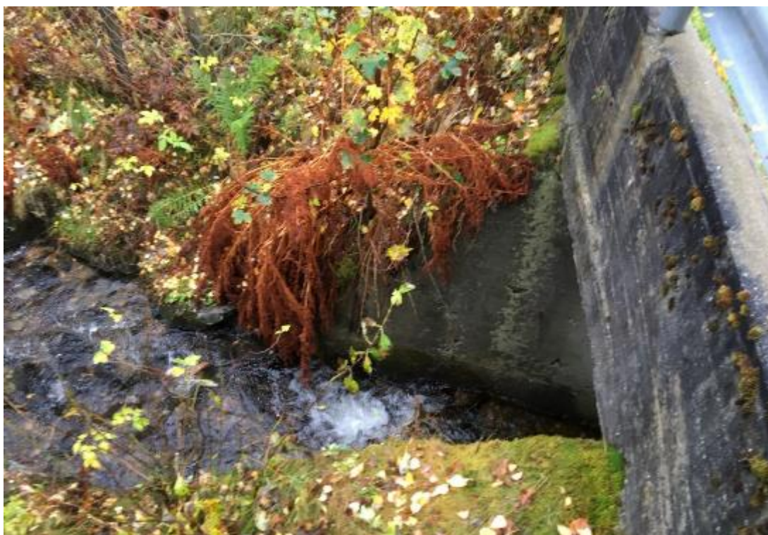
Figur 5-36 Skulevegen pkt 18, bru – utløpsside
