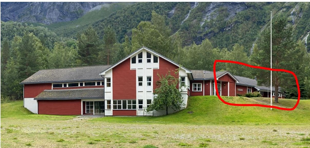
Figur 5 Foto av Todarvoll (tidligere Tafjord skole). Vestfløyen som er planlagt ombygd til hybler er markert med rødt.
