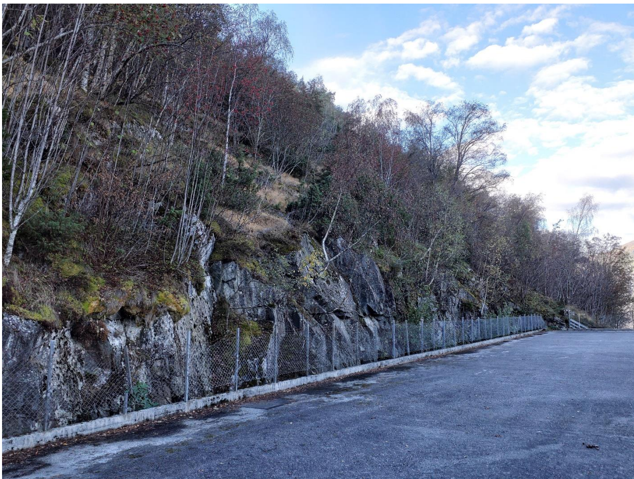
Figur 10: Eksisterende bergskjæring ved påhuggsområde.
